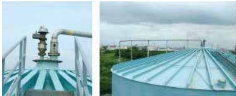
รูปที่ 5-53 การติดตั้ง Pressure Release Valve
