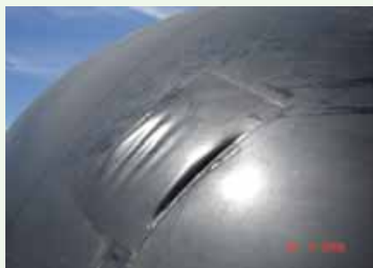
รูปที่ 5-39 การเชื่อมพลาสติกในกรณีที่พลาสติกเกิดการรั่ว
