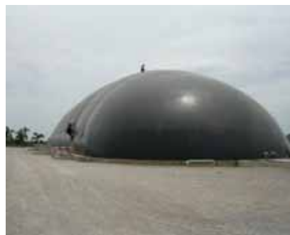
รูปที่ 1-7 บ่อ Modified Covered Lagoon
