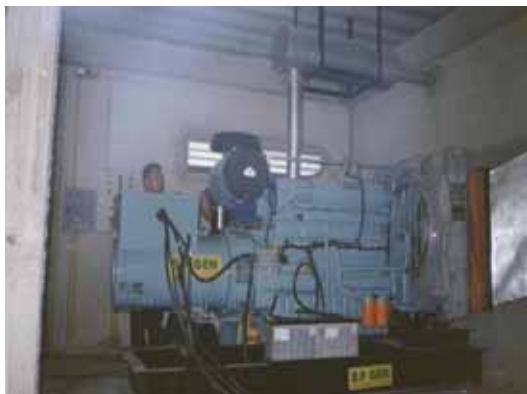
รูปที่ 3-35 เครื่องยนต์ที่ใช้ก๊าซโดยเฉพาะ (เครื่องยนต์นำเข้า) โดยต่อร่วมกับ Synchronous Generator ในการผลิตไฟฟ้า
