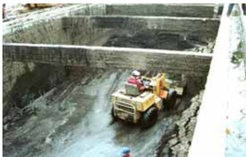
รูปที่ 5-37 บ่อหมักวางเมื่อมีการลงไปบำรุงรักษา (ดักตะกอนส่วนเกินออก)
