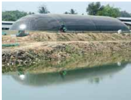
รูปที่ 3-12 โครงสร้างบ่อเก็บก๊าซชีวภาพที่เป็นวัสดุ PVC และ Membrane
