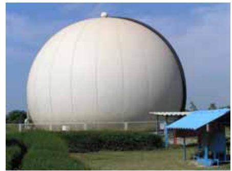
รูปที่ 3-12 โครงสร้างบ่อเก็บก๊าซชีวภาพที่เป็นวัสดุ PVC และ Membrane
