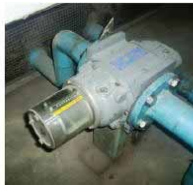
รูปที่ 5-58 เครื่องวัดอัตราการไหลของก๊าซแบบ Thermal Mass Flow Meter และแบบวัดปริมาตรของก๊าซที่ไหลผ่าน
