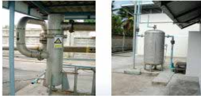
รูปที่ 5-48 ชุดโซโคลนตักน้ำก่อนเข้าไปในอุปกรณ์ใช้งาน
