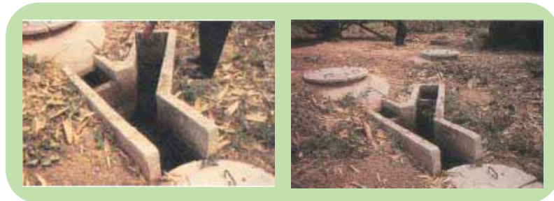
รูปที่ 5-18 การดึ่งลิ้นชักดึ่งกาก และปิดให้สนิทดังเดิม
