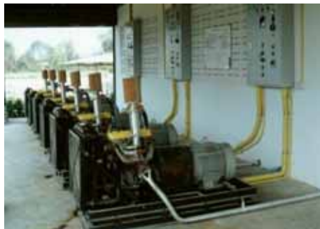
รูปที่ 3-33 เครื่องยนต์เบนซินดัดแปลงให้ใช้ก๊าซชีวภาพได้ 100 % ต่อร่วมกับ
