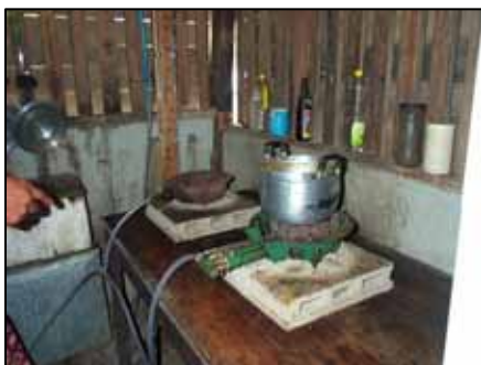
รูปที่ 3-31 การนำก๊าซชีวภาพไปใช้ในรูปของความร้อนโดยตรง
