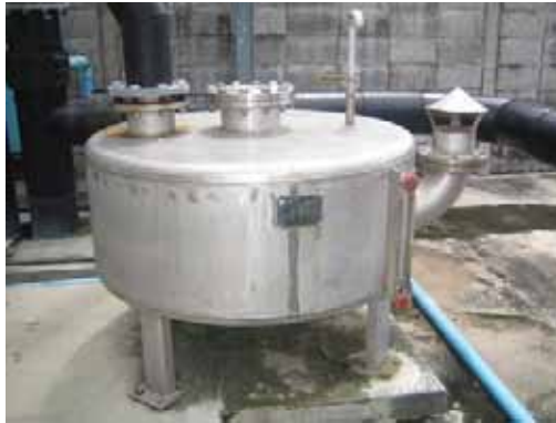
รูปที่ 3-14 ถังป้องกันความดันสูงหรือต่ำของบ่อก๊าซ (Water Seal Tank)
