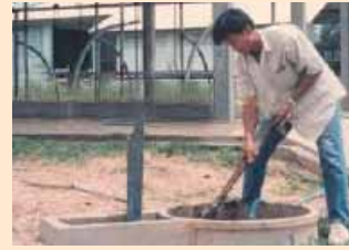
รูปที่ 5-16 การทำความสะอาดบ่อเติม และการใช้ไม้กระทุ้งบ่อเติม
