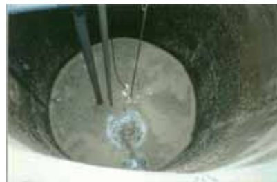
รูปที่ 5-34 แสดงบ่อรวมน้ำเสียที่ยังไม่ได้เดินระบบ รูปที่ 5-35 แสดงบ่อรวมน้ำเสียที่เดินระบบแล้ว
