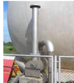
รูปที่ 3-12 โครงสร้างบ่อเก็บก๊าซชีวภาพที่เป็นวัสดุ PVC และ Membrane
