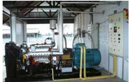
รูปที่ 3-34 เครื่องยนต์ดีเซลดัดแปลงให้ใช้ก๊าซชีวภาพแทนได้ทั้งหมดต่อร่วมกับ Synchronous/Induction Generator เพื่อผลิตไฟฟ้า
