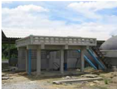
รูปที่ 5-36 บ่อดักทรายที่มีทางเดินโดยรอบและมีบันไดขึ้นลงอย่างสะดวก
