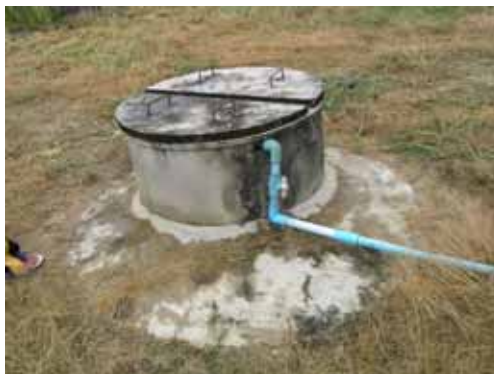
รูปที่ 3-9 โครงสร้างบ่อหมักที่เป็นบ่อก่ออิฐฉาบปูน
