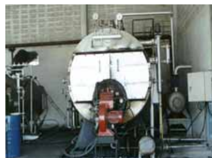
รูปที่ 3-31 การนำก๊าซชีวภาพไปใช้ในรูปของความร้อนโดยตรง
