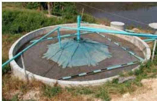
รูปที่ 5-27 บ่อหมัก UASB
