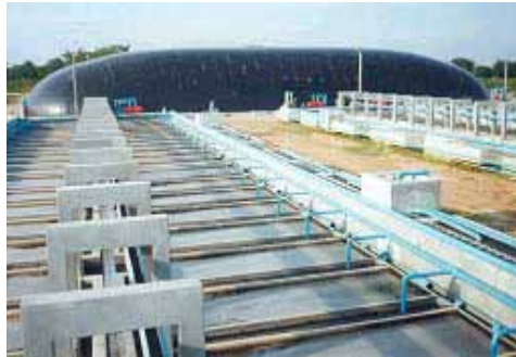
รูปที่ 1-6 บ่อหมักเร็วน้ำขึ้นแบบ H-UASB
