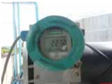
รูปที่ 3-16 ตัวส่งสัญญาณแรงดันก๊าซ (Pressure Transmitter)
