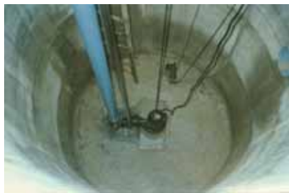
รูปที่ 5-34 แสดงบ่อรวมน้ำเสียที่ยังไม่ได้เดินระบบ รูปที่ 5-35 แสดงบ่อรวมน้ำเสียที่เดินระบบแล้ว
