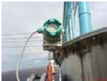
รูปที่ 3-15 สวิตช์ป้องกันความดันสูงหรือต่ำเกินกำหนด (Pressure & Vacuum Switch)
