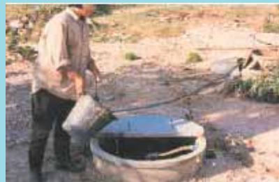
รูปที่ 5-17 หมั่นเติมน้ำบนฝาบ่อ และปิดทุกครั้ง
