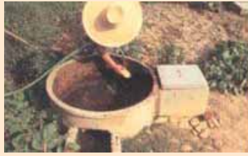
รูปที่ 5-16 การทำความสะอาดบ่อเติม และการใช้ไม้กระทุ้งบ่อเติม
