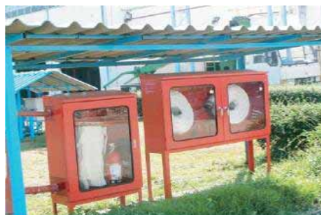
รูปที่ 3-38 การติดตั้งถังดับเพลิงใกล้ถังเก็บก๊าซชีวภาพ
