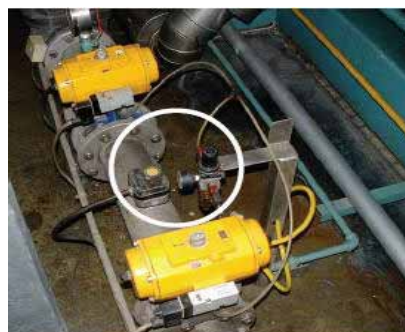
รูปที่ 5-56 Pressure Switch และรูปแบบการติดตั้ง
