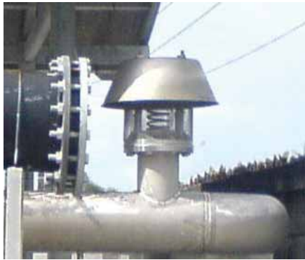
รูปที่ 3-24 วาล์วป้องกันความดันสูงเกินกำหนด (Pressure Relief Valve)
