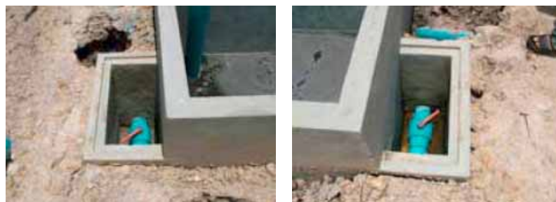
รูปที่ 5-4 วาล์วที่บริเวณบ่อดักกาก ที่ทำหน้าที่ปรับอัตราการไหลของน้ำส่วนใสจากบ่อหมักทรง ซึ่งวาล์ว ทั้ง 2 ตัว ต้องปรับให้เท่ากัน
