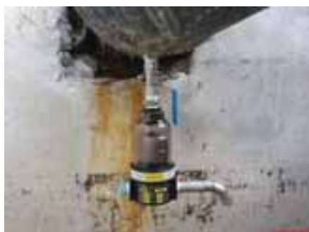
รูปที่ 3-28 อุปกรณ์ดักน้ำออกจากท่อส่งจ่ายก๊าซ Drip Trap – Automatic
