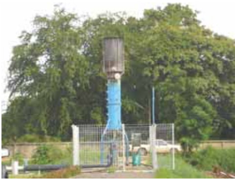
รูปที่ 3-37 ปล่องเผาก๊าซชีวภาพทิ้ง (Flare)
