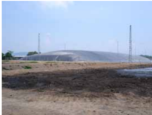
รูปที่ 3-1 การติดตั้งสายล่อฟ้าในระบบผลิตก๊าซชีวภาพ
