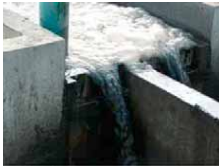
รูปที่ 5-2 การไหลของน้ำเสียที่มีอัตราการไหลสูงเกินไปจนน้ำเสียไหลล้นเวียร์
