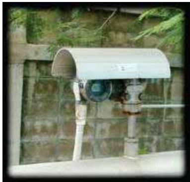
รูปที่ 5-58 เครื่องวัดอัตราการไหลของก๊าซแบบ Thermal Mass Flow Meter และแบบวัดปริมาตรของก๊าซที่ไหลผ่าน
