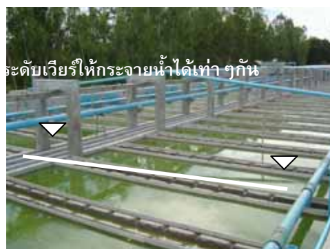
รูปที่ 5-33 บ่อหมัก H-UASB
