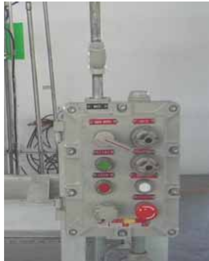
รูปที่ 3-8 การเดินท่อร้อยสายไฟในพื้นที่อันตรายอุปกรณ์ไฟฟ้าจะต้องเป็นชนิดทนระเบิด
