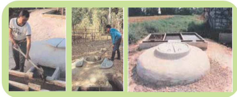
รูปที่ 5-19 การทำความสะอาดปากบ่อล้น ทะลวงท่อ และปิดปากท่อล้นให้เรียบร้อย
