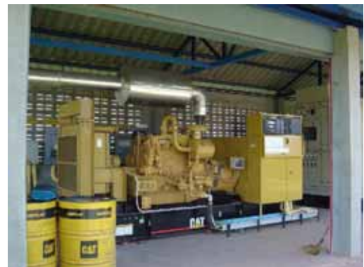
รูปที่ 3-35 เครื่องยนต์ที่ใช้ก๊าซโดยเฉพาะ (เครื่องยนต์นำเข้า) โดยต่อร่วมกับ Synchronous Generator ในการผลิตไฟฟ้า
