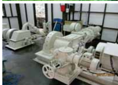
เครื่องกังหันน้ำโรงไฟฟ้าพลังน้ำแม่กำปอง 1,2
