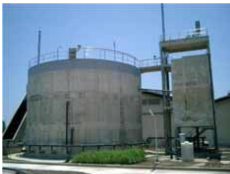
รูปแสดงลักษณะของระบบผลิตก๊าซชีวภาพแบบUpflow Anaerobic Sludge Blanket
