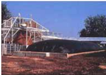
รูปแสดงบ่อหมักข้าแบบราง (Plug Flow digester)
