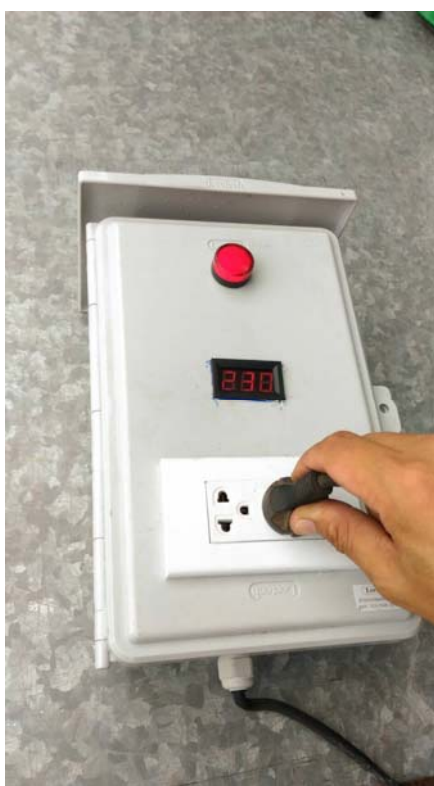
รูปที่ A3 เครื่องเผาไหม้แก๊สที่ต่อเข้ากับแหล่งจ่ายไฟของเครื่องควบคุมไฟตก
