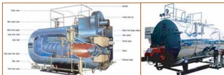
รูปแสดงหม้อไอน้ำชนิดท่อไฟ
