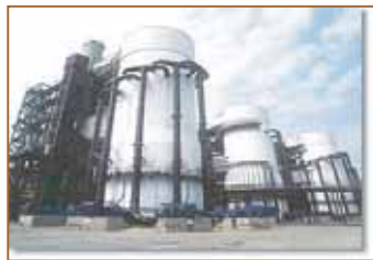
รูปแสดงระบบ Flue Gas Desulfurization (FGD)
