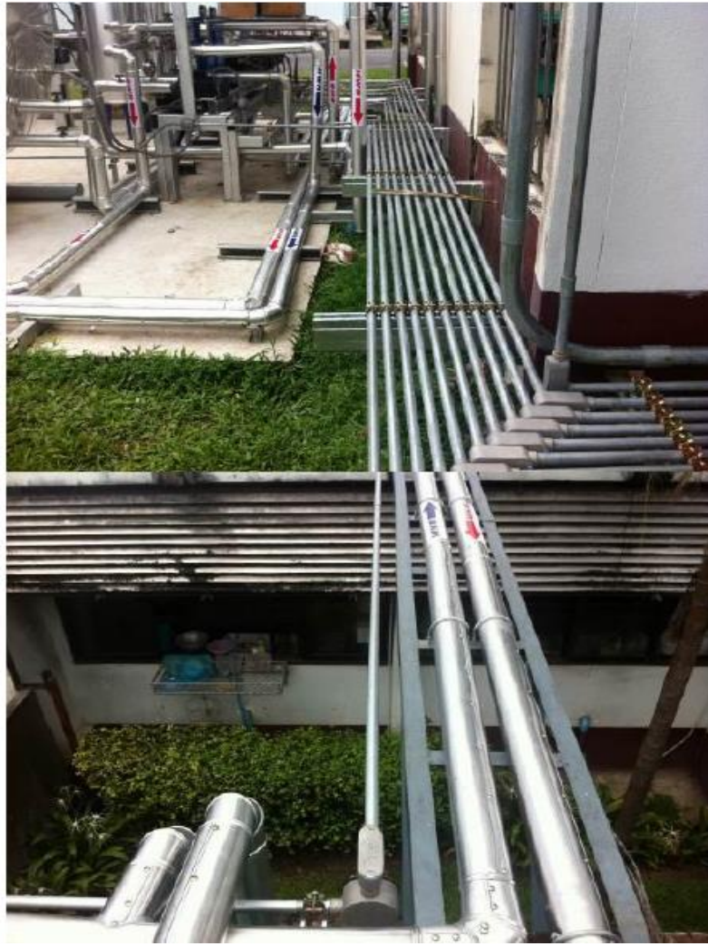
รูปที่ 13 แสดงการติดตั้งท่อ
