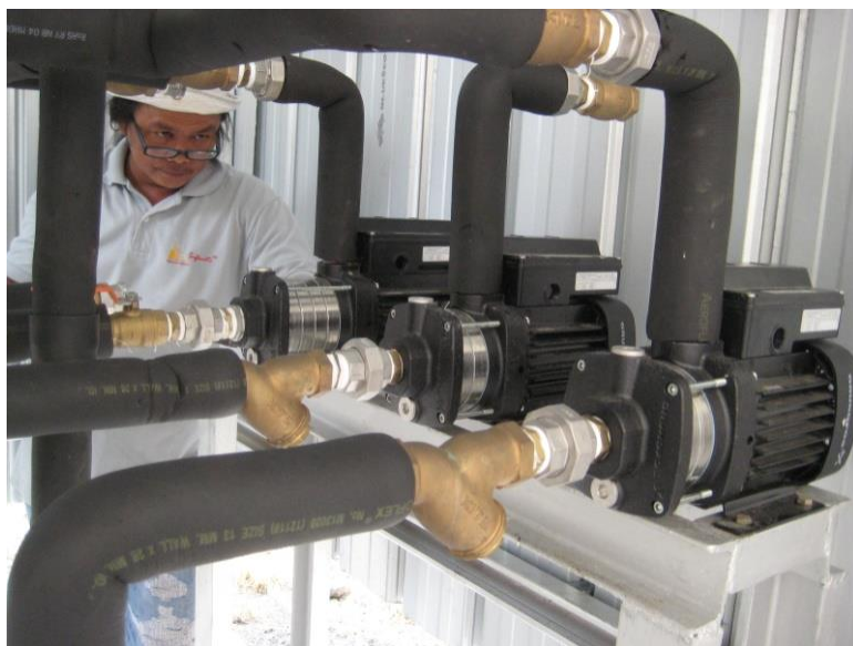
รูปที่ 10 แสดงการติดตั้งเครื่องสูบน้ำหมุนเวียน
