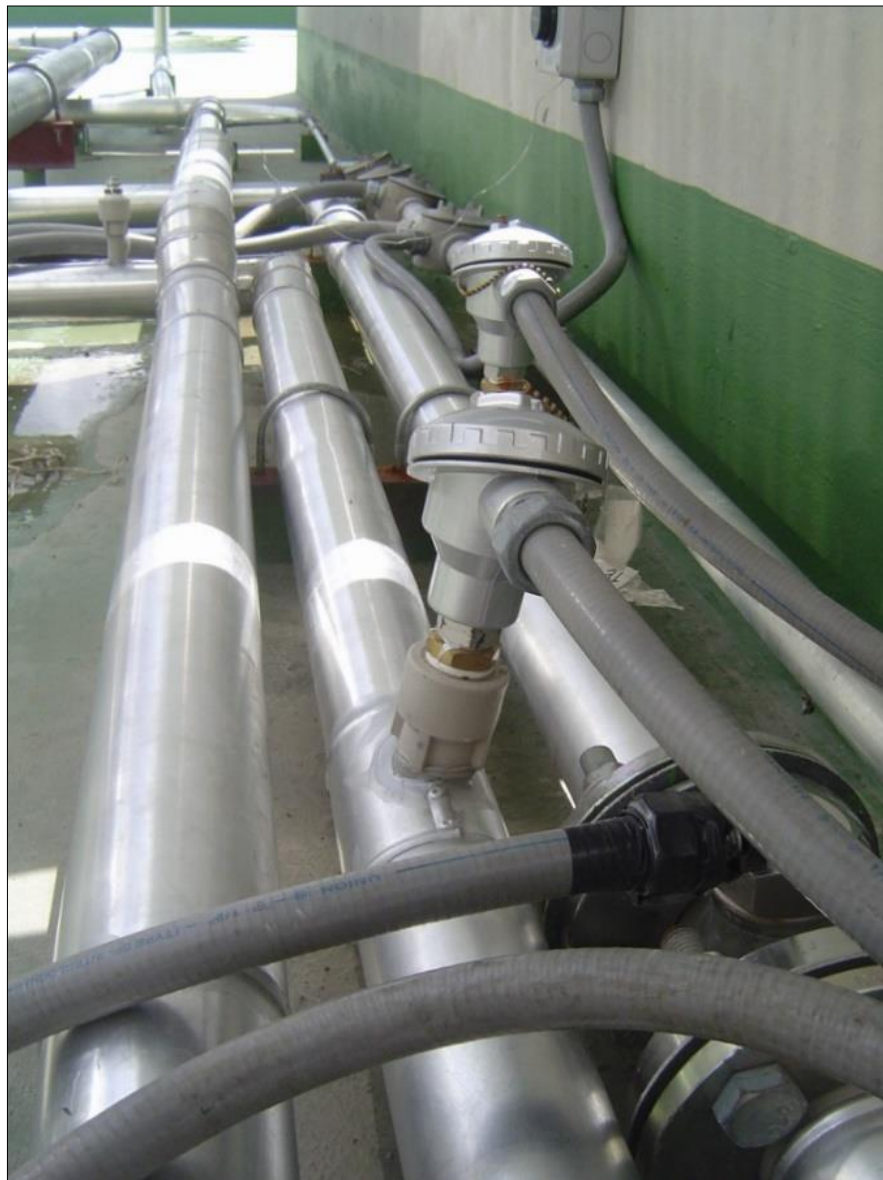
รูปที่ 15 แสดงการติดตั้งมาตรวัดอุณหภูมิตามจุดต่าง ๆ
