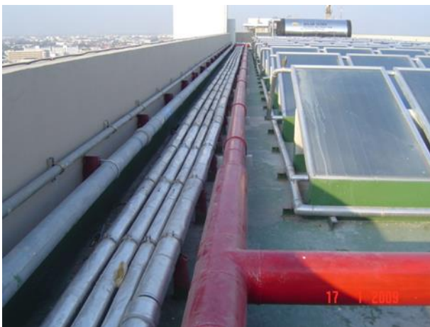
รูปที่ 4 แสดงการต่อท่อเข้าตัวเก็บแสงอาทิตย์และการเสริมคานรับน้ำหนัก
