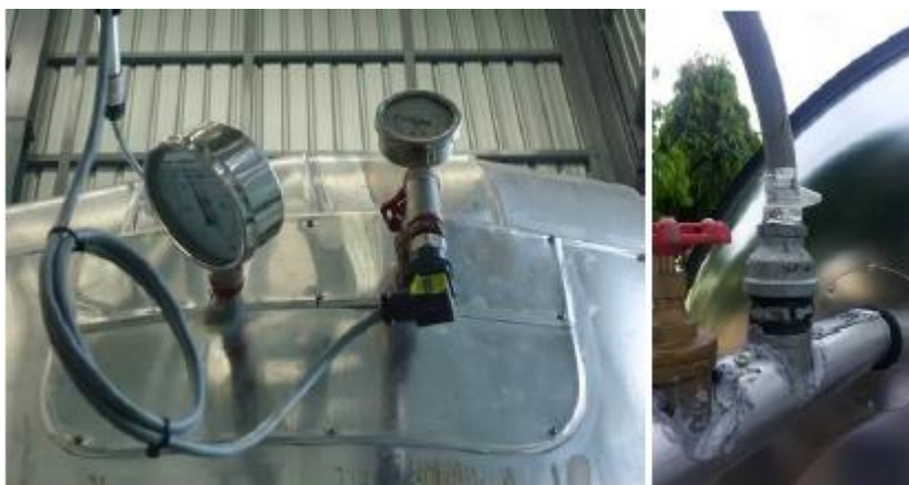
รูปที่ 7 การติดตั้งท่อ ข้อต่อ วาล์ว และอุปกรณ์อื่น ๆ
