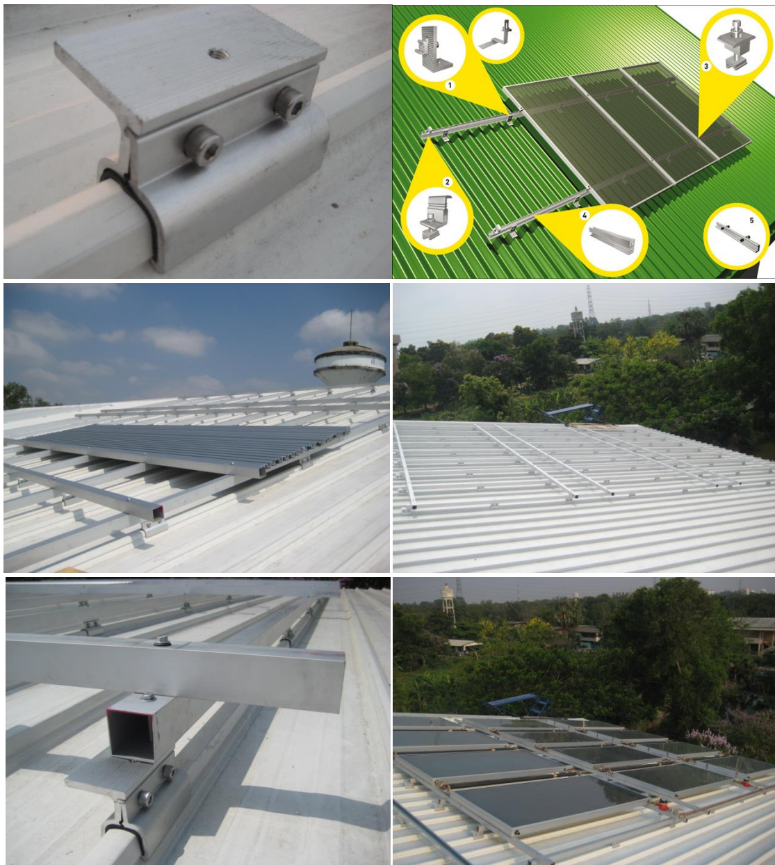
รูปที่ 2 ตัวอย่างอุปกรณ์ยึดจับตัวเก็บรังสีอาทิตย์เข้ากับหลังคา โดยไม่ต้องเจาะหลังคา
