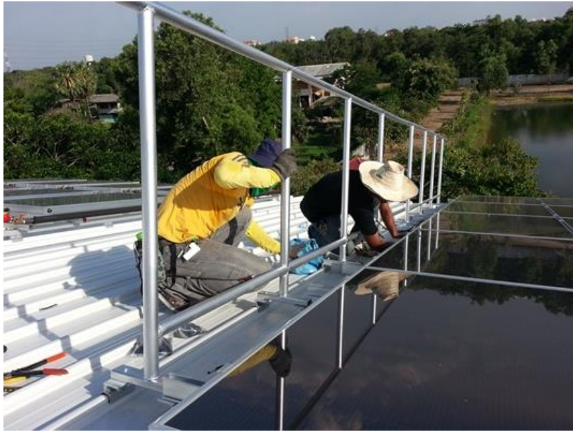
รูปที่ 3 แสดงการติดตั้งราวกันตกเพื่อความปลอดภัย
