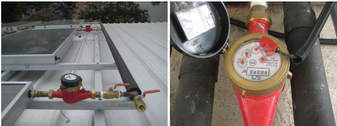
รูปที่ 14 แสดงการติดตั้งมาตรวัดน้ำ
