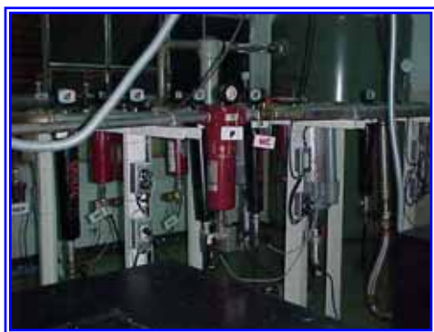
รูปที่ 6.1-26 การติดตั้งชุดกรองอากาศอัดที่เกินความจำเป็น
