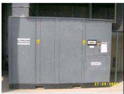
เครื่องอัดอากาศขนาด 255 กิโลวัตต์
