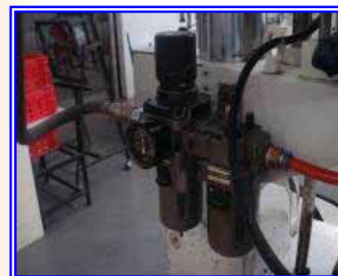
เปลี่ยนข้อต่อท่อลมยางชุด Air Service ปั๊มสุญ 11 Valve
