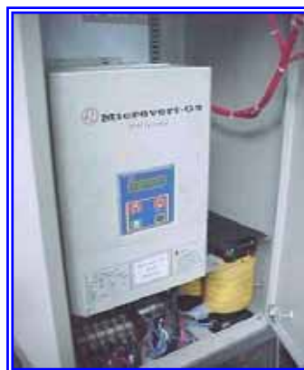
รูปที่ 6.1-12 การติดตั้ง VSD ควบคุมความเร็วรอบเครื่องอัดอากาศ
