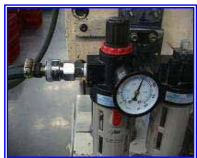
เปลี่ยนข้อต่อท่อลมยางชุด Air Service ของเครื่องปั๊มสุญ 6
