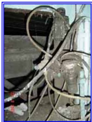
รูปที่ 6.1-24 อุปกรณ์นิวเมติกส์และชุดปรับความดันของอุปกรณ์ที่ขาดการดูแลบำรุงรักษาที่ดี
