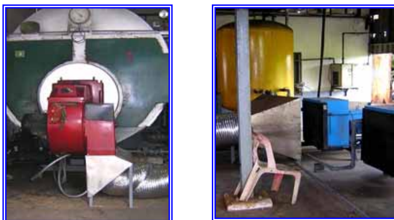
ติดตั้งท่อลมร้อนจากเครื่องอัดอากาศมาอุ่นอากาศเข้าหม้อไอน้ำชุดที่ 1
