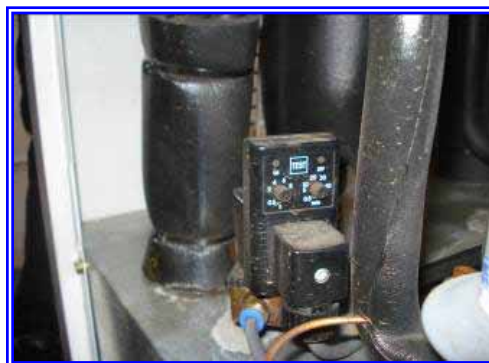
รูปที่ 6.2-5 การตั้งค่าการเตรนก่อนปรับปรุง
