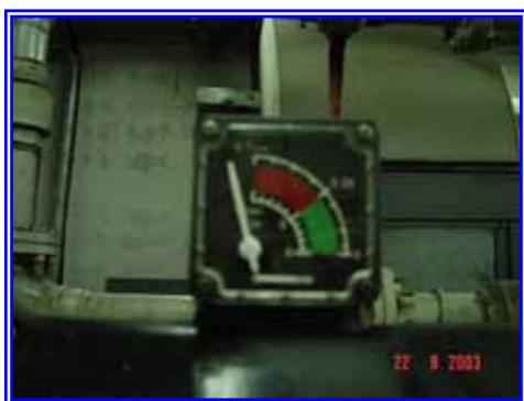
รูปที่ 6.1-25 ชุดกรองน้ำในระบบอากาศอัดเริ่มเสื่อมสภาพและขาดการดูแลบำรุงรักษาที่ดี
