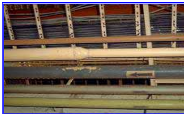
รูปที่ 6.3-2 การลดขนาดท่อหลักที่ทำให้เกิดการสูญเสียความดัน
