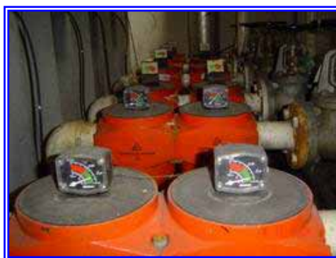
รูปที่ 6.1-25 ชุดกรองน้ำในระบบอากาศอัดเริ่มเสื่อมสภาพและขาดการดูแลบำรุงรักษาที่ดี
