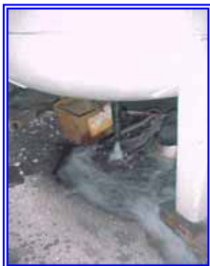
รูปที่ 6.1-23 ถังเก็บอากาศที่ขาดการดูแลบำรุงรักษาที่ดีจะมีน้ำขังในถังเก็บ และจุดระบายน้ำทิ้งชำรุด
