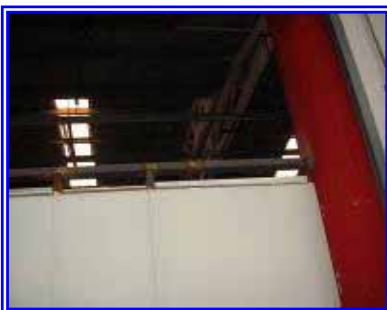
ขันอัด Union ท่อลมเหล็กให้แน่นที่เครื่อง Shrink แผนกเครื่องสำอาง (อยู่ในผ้า)
