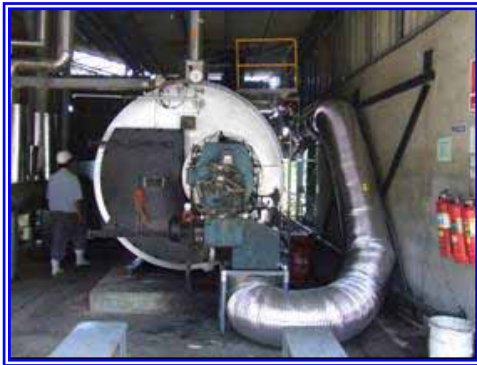
ติดตั้งท่อนำลมร้อนจากเครื่องอัดอากาศมาอุ่นอากาศเข้าหม้อไอน้ำชุดที่ 2 รูปที่ 6.1-19 ติดตั้งท่อนำลมร้อนจากเครื่องอัดอากาศมาอุ่นอากาศเข้าหม้อไอน้ำ
