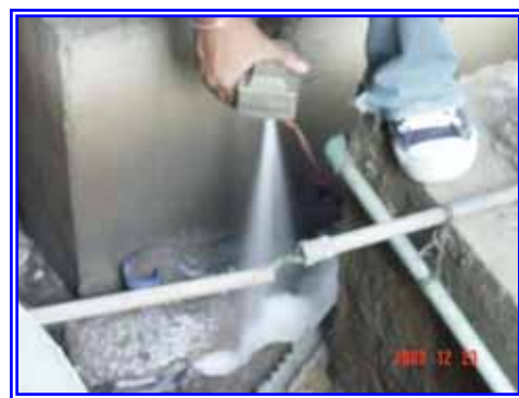
รูปที่ 6.1-23 ถังเก็บอากาศที่ขาดการดูแลบำรุงรักษาที่ดีจะมีน้ำขังในถังเก็บ และจุดระบายน้ำทิ้งชำรุด
