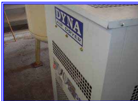
รูปที่ 6.2-1 เครื่องทำอากาศแห้ง (Air Dryer)
