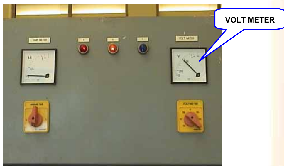
รูปที่ 4.1-1 การตรวจสอบแผงไฟฟ้า
