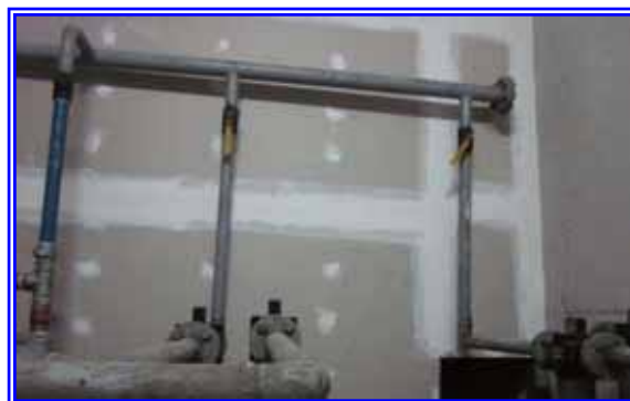
รูปที่ 6.3-6 หลังการปรับปรุงระบบท่ออากาศอัด
