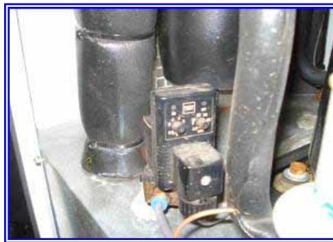
รูปที่ 6.2-6 การเซ็ทค่าการเตรนจาก 6 วินาทีเป็น 4 วินาที
