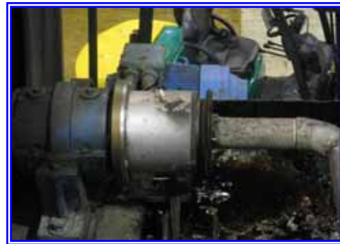
รูปที่ 6.2-11 สภาพหลังการปรับปรุงอากาศอัดรั่วในระบบอากาศอัด
