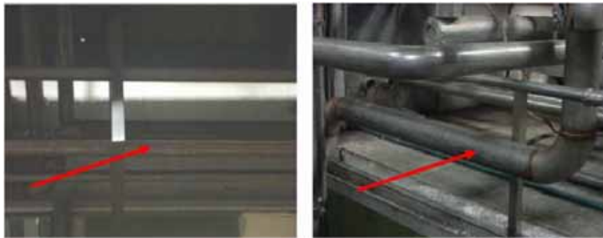
รูปที่ 6.3-4 หลังการปรับปรุงระบบท่ออากาศอัด
