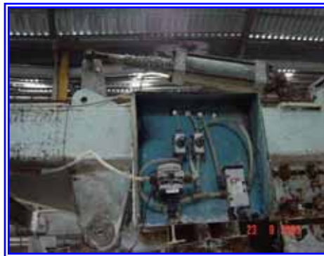
รูปที่ 6.1-24 อุปกรณ์นิวเมติกส์และชุดปรับความดันของอุปกรณ์ที่ขาดการดูแลบำรุงรักษาที่ดี
