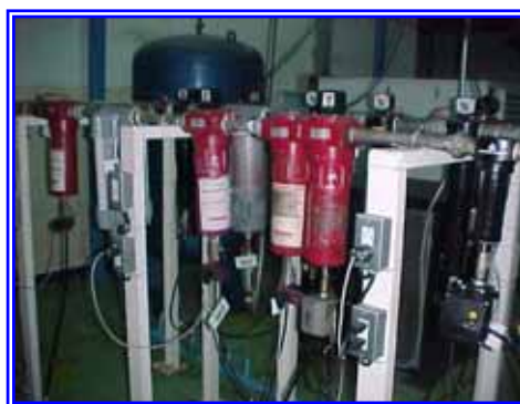
รูปที่ 6.1-26 การติดตั้งชุดกรองอากาศอัดที่เกินความจำเป็น
