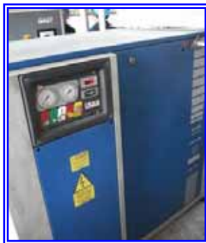
รูปที่ 6.1-5 เครื่องอัดอากาศสกรู ขนาด 37 กิโลวัตต์
