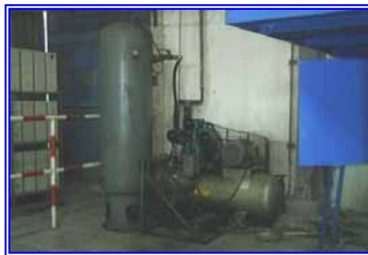
รูปที่ 6.2-9 หลังติดตั้งต่อถังเก็บอากาศอัดเพิ่ม (ถังอากาศอัดแบบแนวดิ่ง)
