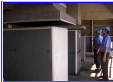
รูปที่ 6.1-5 เครื่องอัดอากาศสกรู ขนาด 37 กิโลวัตต์
