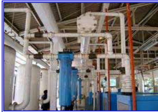
รูปที่ 6.3-1 ท่อหลักส่งจ่ายอากาศอัด
