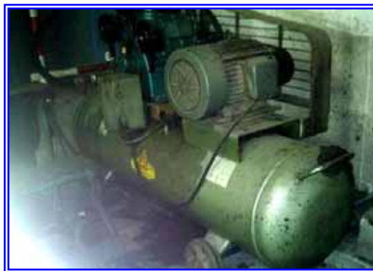
รูปที่ 6.2-8 เครื่องอัดอากาศก่อนปรับปรุงมีถังเก็บอากาศอัด 1 ใบ
