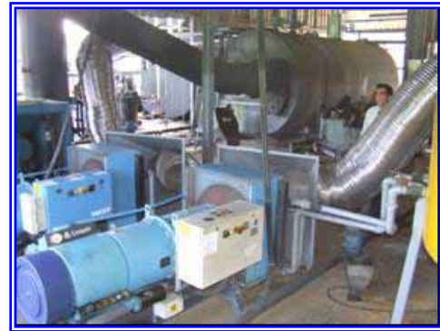
ติดตั้งท่อนำลมร้อนจากเครื่องอัดอากาศมาอุ่นอากาศเข้าหม้อไอน้ำชุดที่ 2 รูปที่ 6.1-19 ติดตั้งท่อนำลมร้อนจากเครื่องอัดอากาศมาอุ่นอากาศเข้าหม้อไอน้ำ
