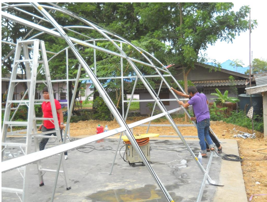
รูปที่ 45 การติดตั้ง Aluminium Clamping บนโครงเหล็กของระบบบอบแห้งฯ
