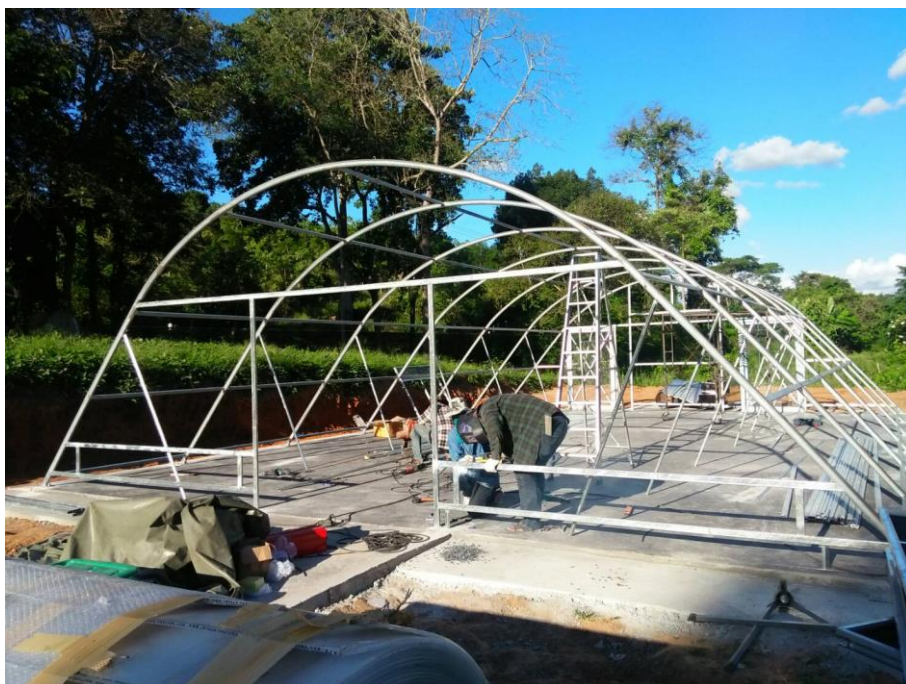
รูปที่ 43 การประกอบโครงเหล็กของระบบบ่อแห้งๆ
