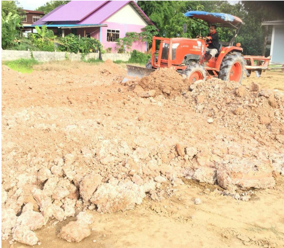
รูปที่ 15 การถมดินปรับพื้นที่สำหรับทำพื้นคอนกรีต
