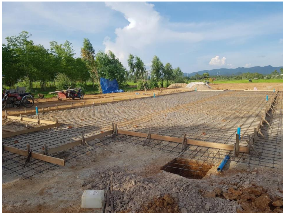
รูปที่ 16 การตีแบบสำหรับเทพื้นคอนกรีตพร้อมฝังท่อระบายน้ำทิ้ง
