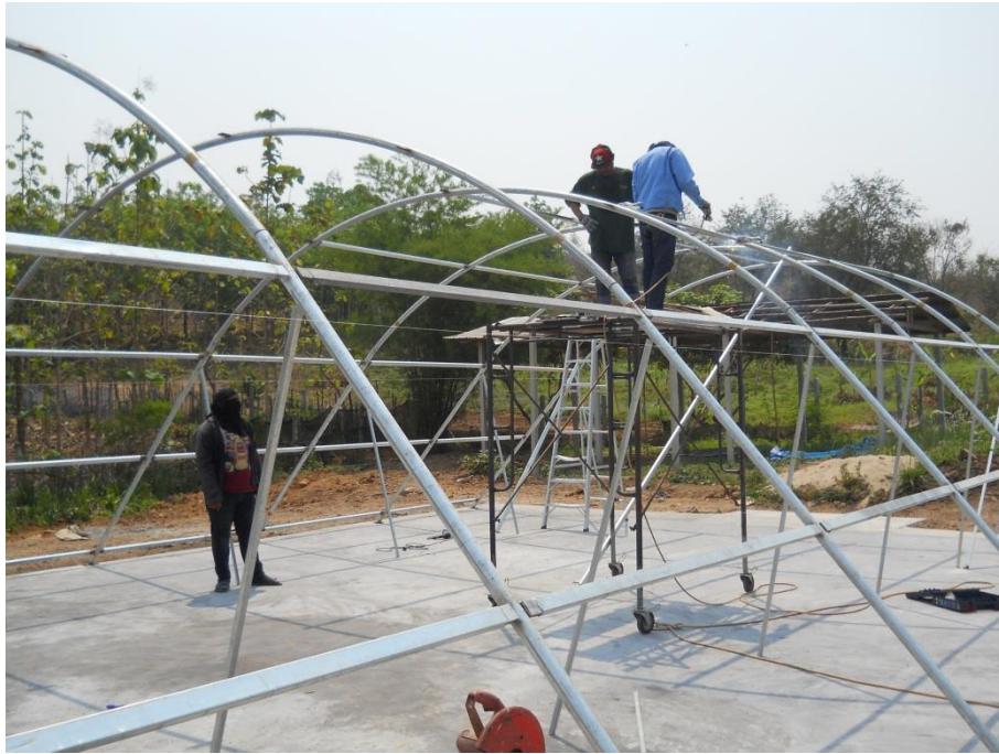
รูปที่ 44 การเชื่อมโครงเหล็กของระบบบอบแห้งฯ
