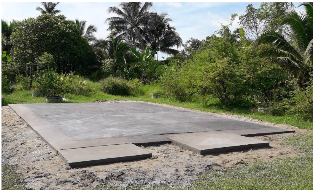
รูปที่ 21 พื้นคอนกรีตที่เสร็จสมบูรณ์
