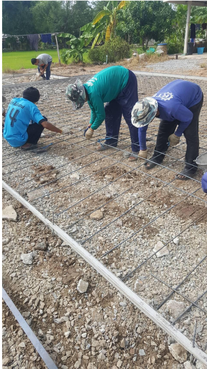
รูปที่ 17 การผูกเหล็กให้ยึดติดกันด้วยลวด
