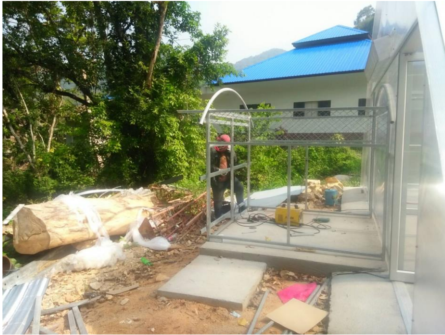
รูปที่ 50 การติดตั้งโรงเก็บเครื่องเผาไหม้แก๊สของระบบอบแห้งฯ
