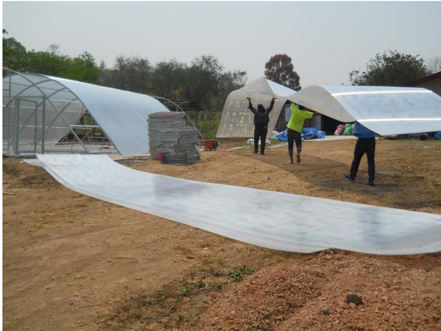
รูปที่ 46 การนำแผ่นโพลีคาร์บอเนตขึ้นบนโครงสร้างของระบบบอบแห้งฯ
