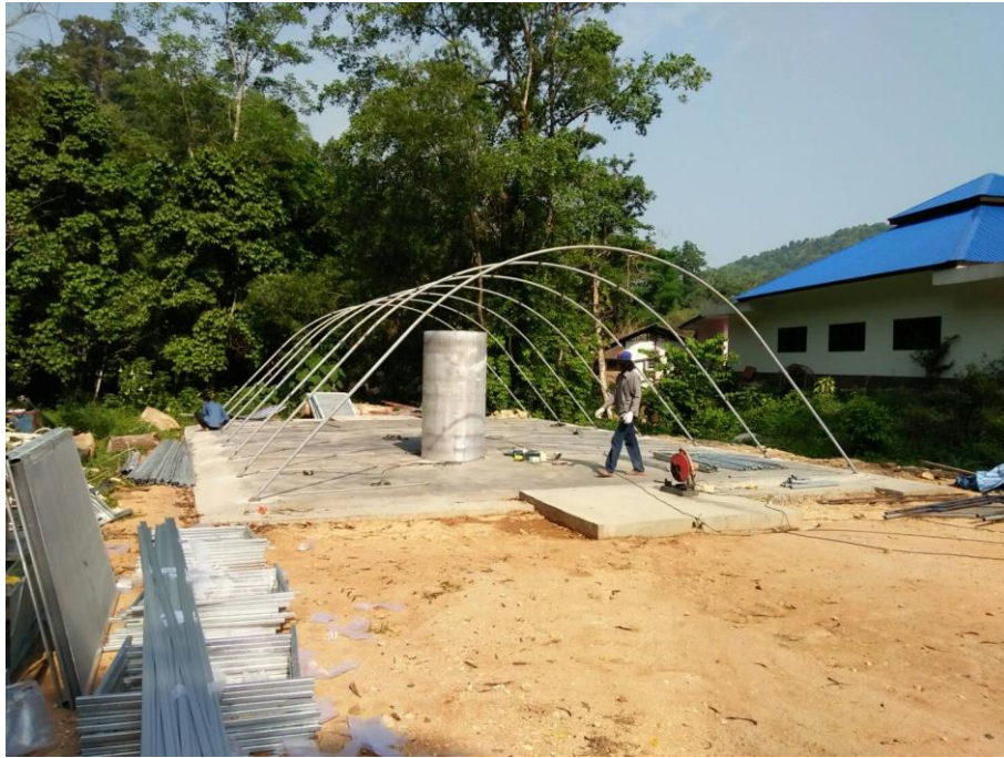
รูปที่ 42 การติดตั้งโครงเหล็กของระบบบ่อแห้งๆ
