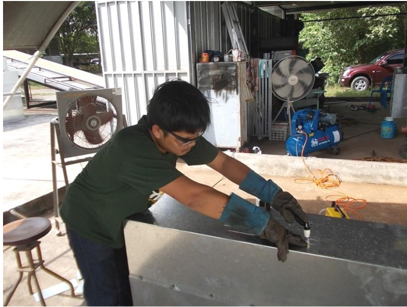
รูปที่ 30 การเตรียมท่ออากาศ
