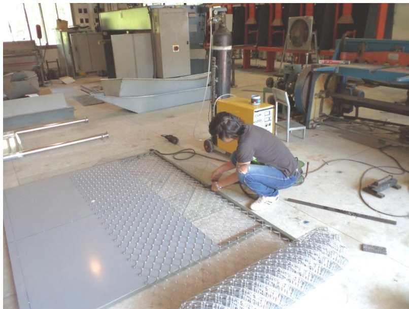
รูปที่ 29 การเตรียมโครงสร้างโรงเก็บเครื่องเผาไหม้แก๊ส
