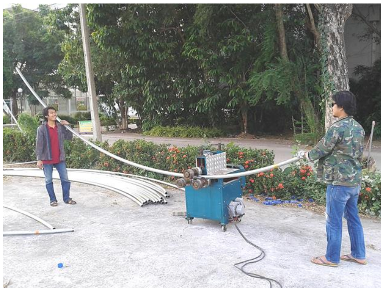
รูปที่ 22 การตัดโค้งเหล็กโครงหลังคา
