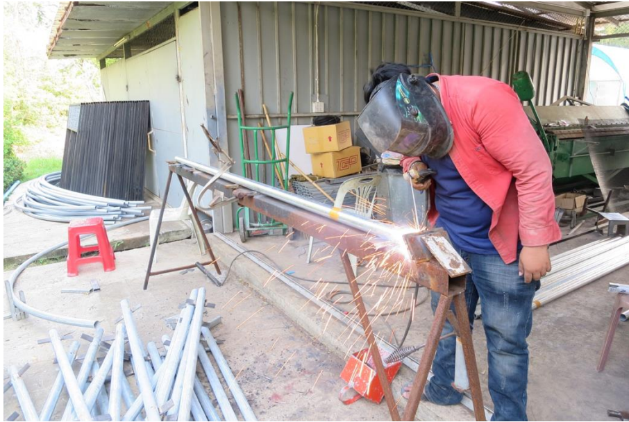
รูปที่ 23 การเตรียมเสาเหล็กโครงหลังคา
