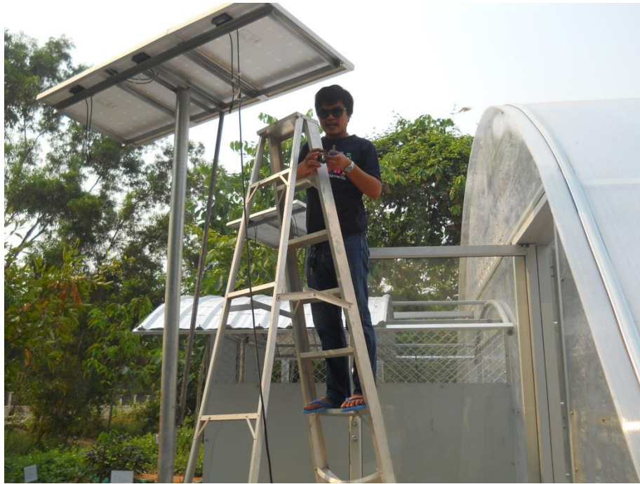
รูปที่ 52 การติดตั้งเสาโซลาร์เซลล์และต่อไฟฟ้าเข้าพัดลม DC 12 V
