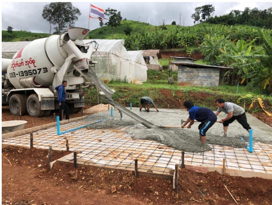
รูปที่ 18 การเทพื้นคอนกรีต
