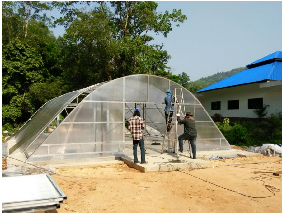
รูปที่ 48 การติดตั้งแผ่นโพลีคาร์บอเนตด้านหน้าโครงสร้างของระบบบอบแห้งฯ
