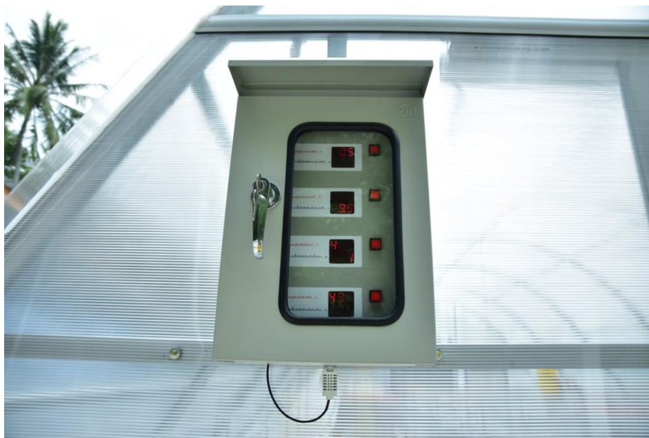
รูปที่ 57 ตู้แสดงค่าอุณหภูมิและความชื้นสัมพัทธ์ของอากาศภายในและภายนอกระบบบอบแห้งฯ ของพพ. 3
