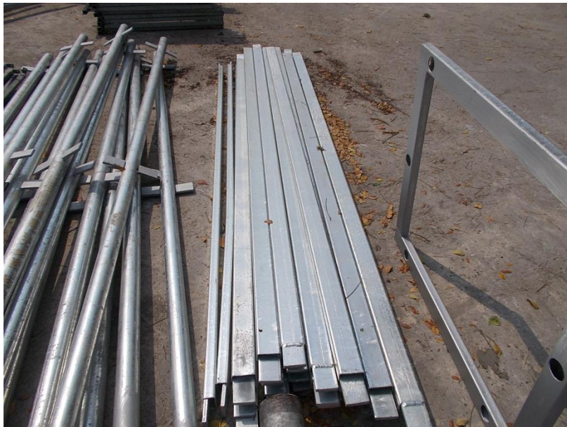
รูปที่ 28 เหล็กโครงด้านข้างที่ซุบกัสนิมแล้ว
