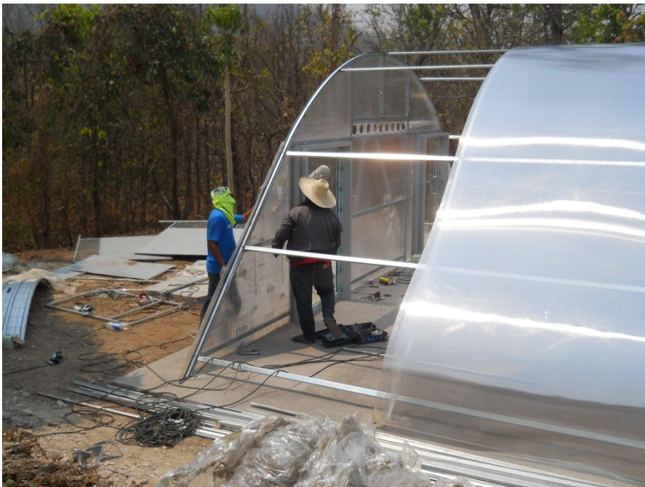
รูปที่ 49 การติดตั้งประตูและแผ่นโพลีคาร์บอเนตด้านหลังโครงสร้างของระบบบอบแห้งฯ
