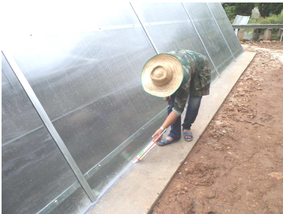
รูปที่ 51 การอุดรอยต่อระหว่างแผ่นโพลีคาร์บอเนตกับพื้นด้วยซิลิโคน
