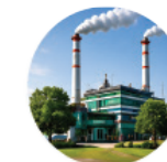
โรงไฟฟ้าชีวมวล
