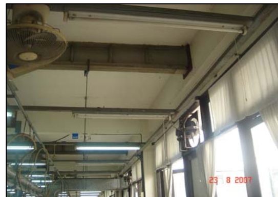
ภาพการติดตั้งสวิตช์ควบคุมประจําโคม และจำนวนโคมไฟฟ้ที่ปิดได้ในแผนกรีด
