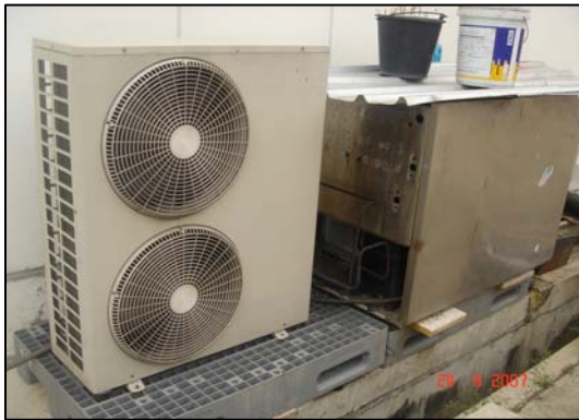
ภาพแสดงเครื่องทำน้ำเย็น และถังน้ำเย็นซึ่งไม่มีฝาปิด
