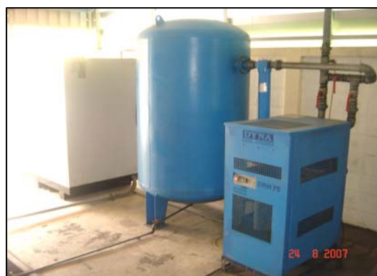
ภาพเครื่องอัดอากาศ และอุปกรณ์ประกอบในระบบ
