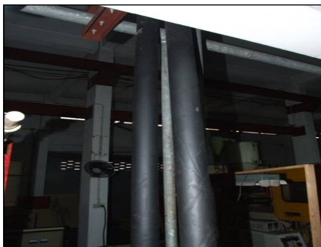
ภาพการฉนวนท่อน้ำเย็น หลังปรับปรุง
