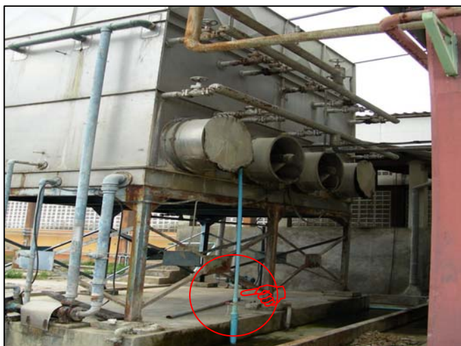
ภาพลักษณะการปรับวาล์วควบคุมการไหลของน้ำ
