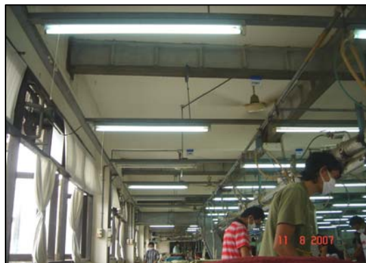
ภาพการติดตั้งสวิตช์ควบคุมประจําโคม และจำนวนโคมไฟฟ้ที่ปิดได้ในแผนกรีด
