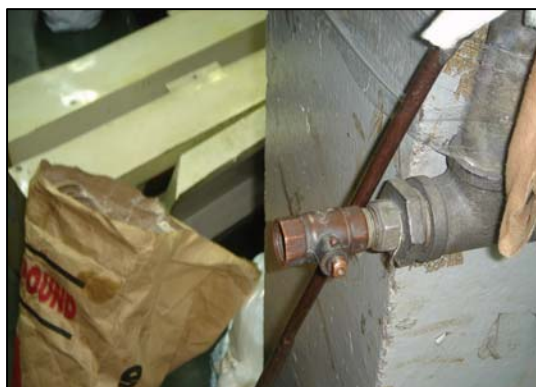
ภาพแสดงจุดที่เกิดการรั่วไหลของอากาศอัด
