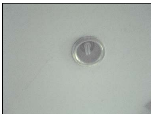
ภาพหลังปรับปรุงใช้หลอดคอมแพกซ์ฟลูออเรสเซนต์แทน
