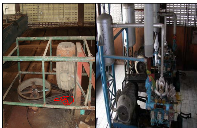
ภาพการใช้งานของสายพานหย่อนที่ชุดมอเตอร์กำลัง
