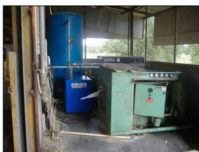
ภาพลักษณะการติดตั้งเครื่องอัดอากาศ
