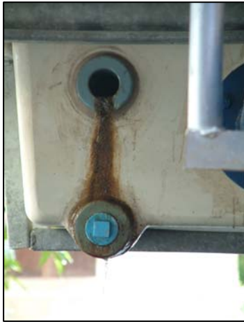
ภาพหอระบายความร้อนและคราบตะกรันที่เกิดขึ้นจากภายใน
