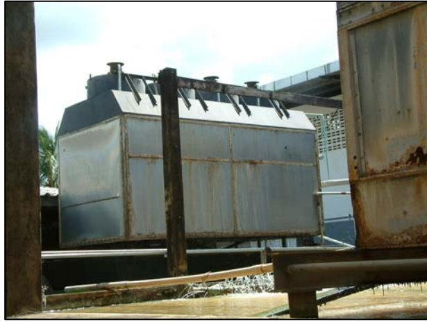
ภาพหอระบายความร้อนและคราบตะกรันที่เกิดขึ้นจากภายใน
