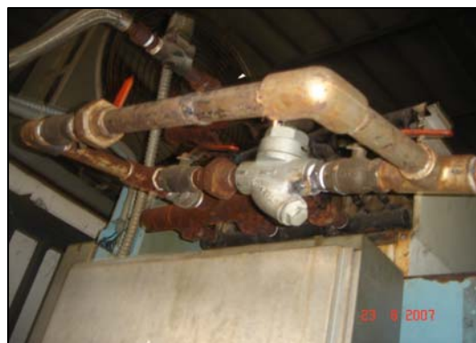
ภาพกับดักไอน้ำ เครื่องอบ#5 หลังปรับปรุง และกับดักไอน้ำ เครื่องอบ#7 หลังปรับปรุง
