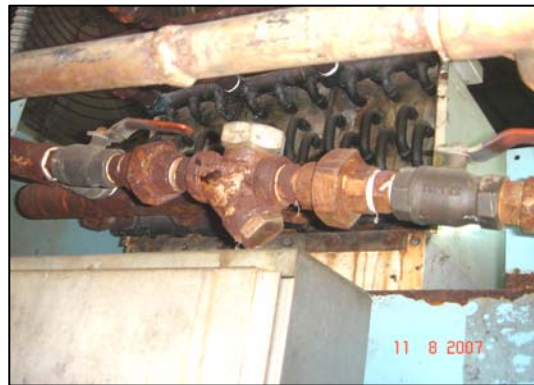
ภาพกับดักไอน้ำที่ชำรุดแบบปิดค้าง(เครื่องอบ#5) และกับดักไอน้ำที่ชำรุดแบบเปิดค้าง (เครื่องอบ#7)
