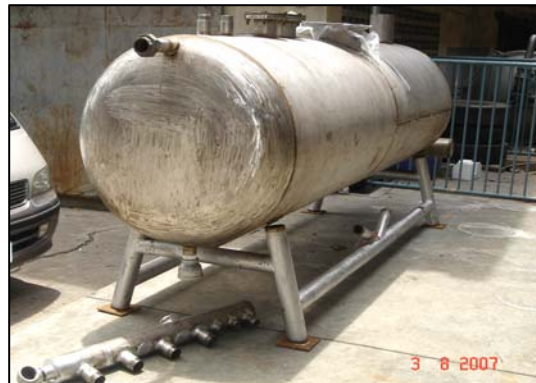
ภาพถังน้ำป้อนใหม่ระหว่างเตรียมการติดตั้ง
