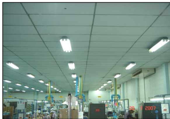
ภาพการติดตั้ง และลักษณะของโคมไฟฟ้า
