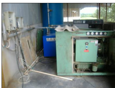
ภาพเครื่องอัดอากาศที่ระบายอากาศร้อนเข้ากำแพง
