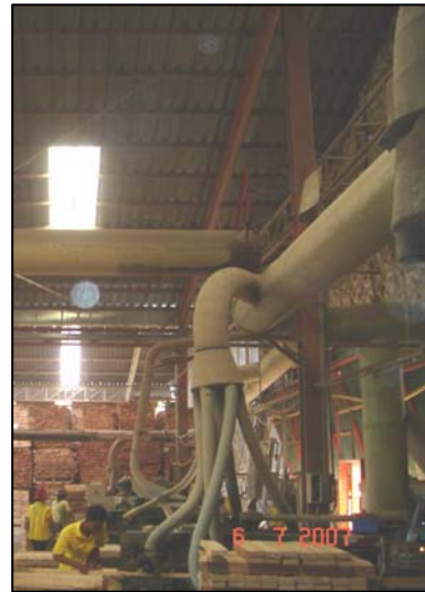
ภาพและท่อลมดูดฝุ่นที่ติดตั้งใช้งานก่อนการปรับปรุง
