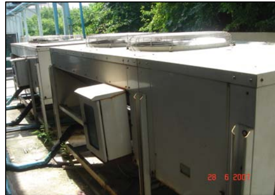
ภาพเครื่องทำน้ำเย็นที่ใช้หล่อเย็นถุงจากเครื่องเป่าหมายเลข 1-2 และหมายเลข 3-5 ตามลำดับ
