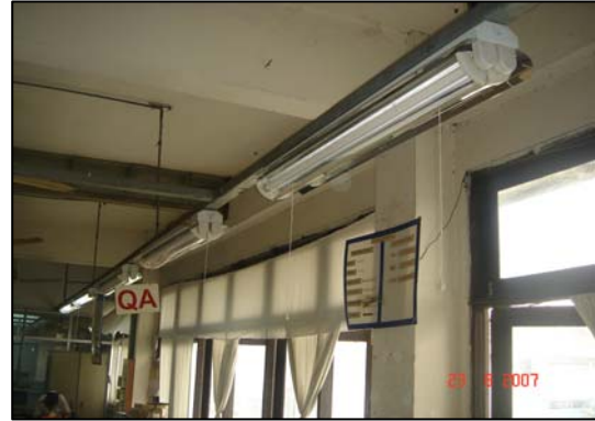
ภาพแสดงการติดตั้งสวิตช์ควบคุมประจําโคม และจำนวนโคมไฟฟ้ที่ปิดได้ในแผนก QA
