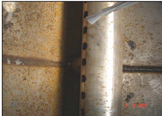
ภาพท่อคอนเดนเสทเจาะรูบริเวณก้นถังน้ำป้อนใหม่ และซากถังน้ำป้อน และอุปกรณ์ประกอบเดิม
