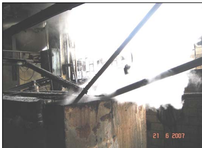
ภาพถังน้ำป้อนหม้อไอน้ำ และการสูญเสียไอน้ำ (Flash Steam)
