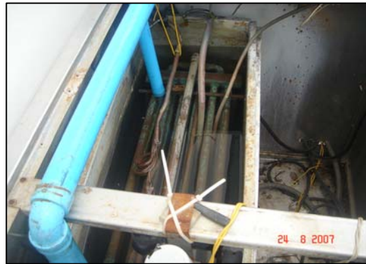
ภาพแสดงเครื่องทำน้ำเย็น และถังน้ำเย็นซึ่งไม่มีฝาปิด
