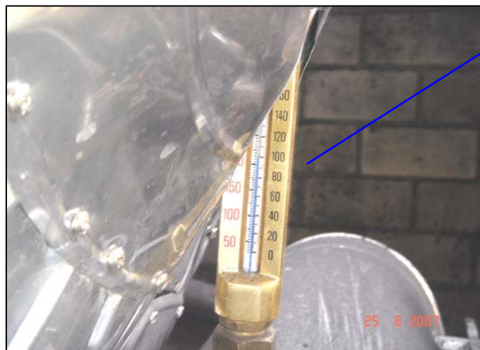
ภาพแสดงค่าอุณหภูมิน้ำป้อนหม้อไอน้ำหลังการปรับปรุง
