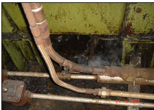
ภาพอุปกรณ์ต่างๆที่ชำรุดและเกิดการรั่วไหลของไอน้ำ
