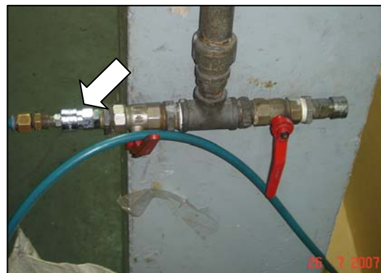
ภาพตัวอย่างอุปกรณ์ที่ดำเนินการเปลี่ยนเพื่อลดการรั่วไหลของอากาศอัด
