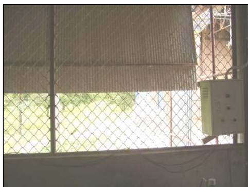
ภาพช่องระบายอากาศที่ใช้ระบายความร้อน
