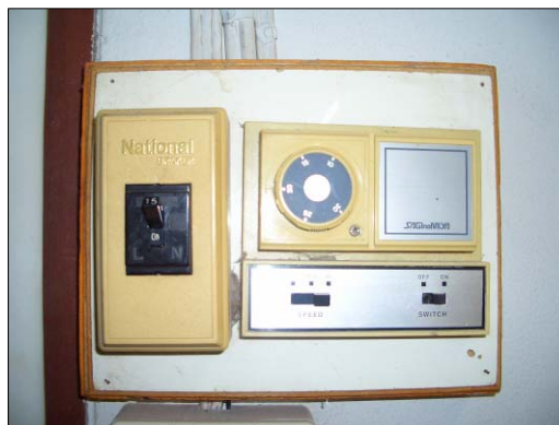
ภาพก่อนปรับปรุง
