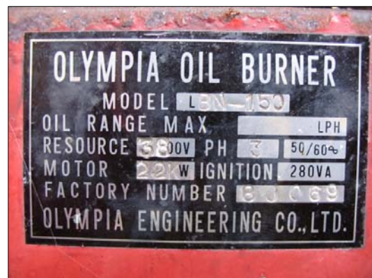
ภาพลักษณะของหม้อไอน้ำของโรงงาน และ Name plate ของ Oil Burner
