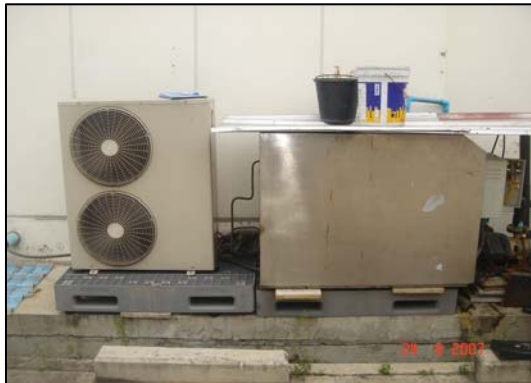
ภาพเครื่องทำน้ำเย็นที่ใช้หล่อเย็นถุงจากเครื่องเป่าหมายเลข 1-2 และหมายเลข 3-5 ตามลำดับ
