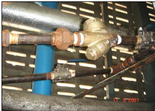
ภาพกับดักไอน้ำที่ชำรุดแบบปิดค้าง(เครื่องอบ#5) และกับดักไอน้ำที่ชำรุดแบบเปิดค้าง (เครื่องอบ#7)
