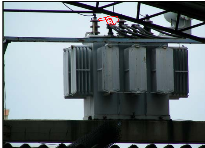
ภาพตำแหน่งการปรับแทปแรงดันของหม้อแปลงไฟฟ้า
