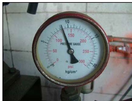
ภาพก่อนปรับปรุง
