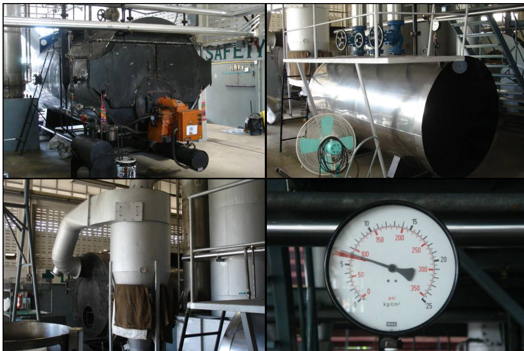
ภาพหม้อไอน้ำขนาด 4 ตัน/ชั่วโมง
