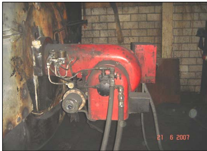
ภาพหัวเผา น้ำมันเตาของหม้อไอน้ำ
