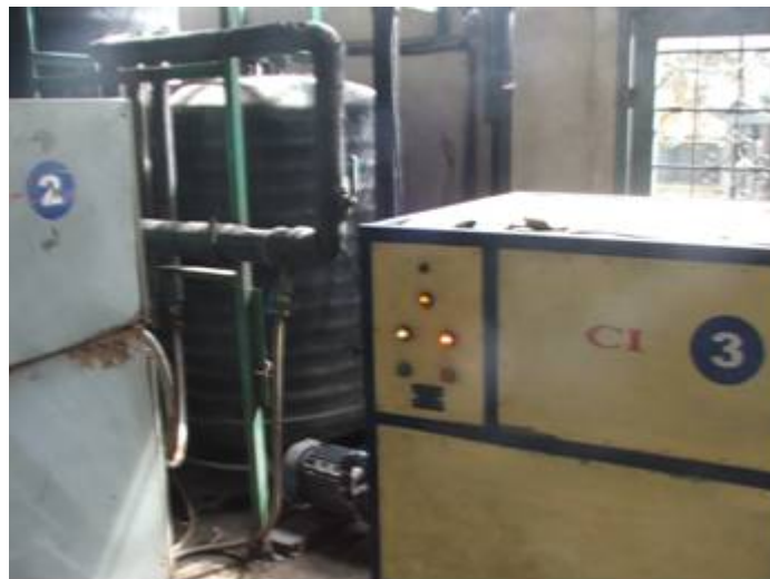
ภาพ Chiller ขนาด 4.5 kW
