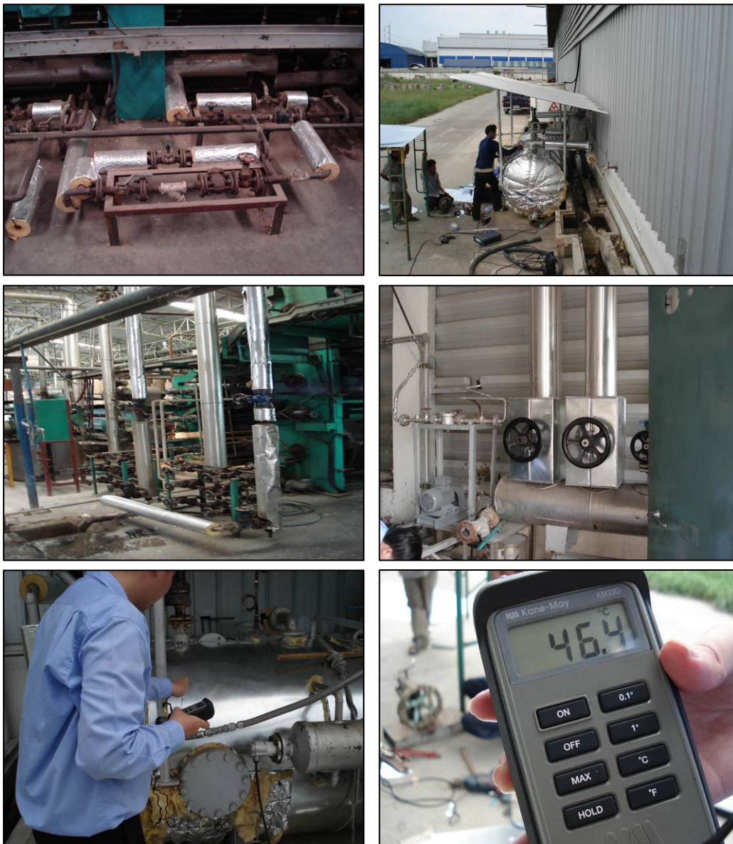
ภาพทำการหุ้มฉนวนและอุณหภูมิหลังปรับปรุง
