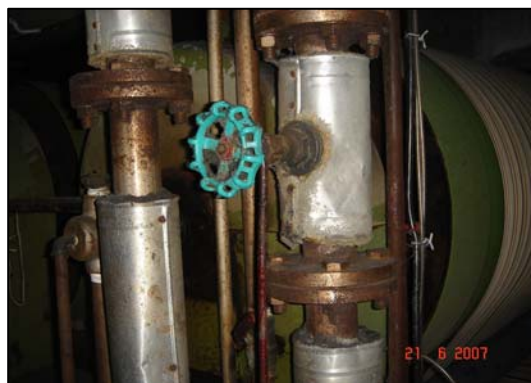
ภาพอุปกรณ์ต่างๆที่ชำรุดและเกิดการรั่วไหลของไอน้ำ
