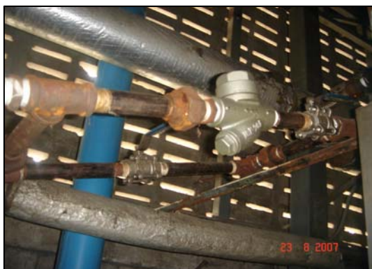
ภาพกับดักไอน้ำ เครื่องอบ#5 หลังปรับปรุง และกับดักไอน้ำ เครื่องอบ#7 หลังปรับปรุง
