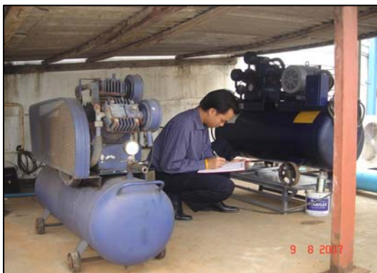
ภาพแสดงการตรวจวัดประสิทธิภาพการผลิตอากาศอัด และพลังไฟฟ้าของเครื่องอัดอากาศหลังปรับปรุง
