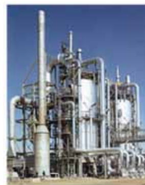
เตาเผาขยะแบบฟลูอิดไดซ์เบด
