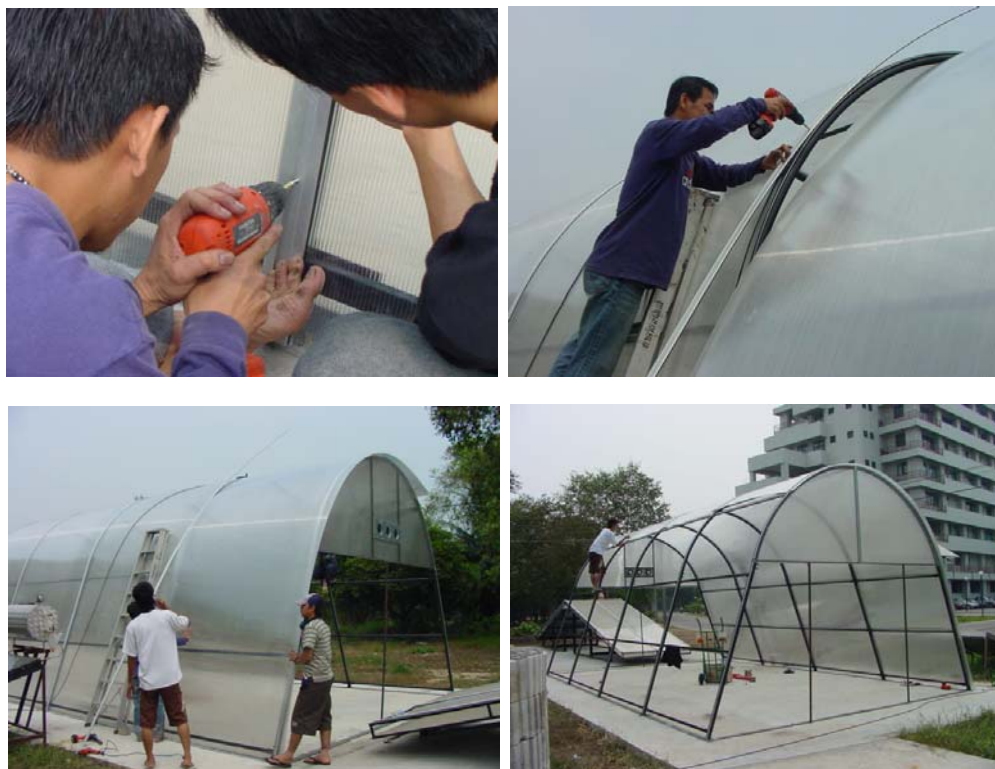
รูปที่ 2.13 แสดงการติดแผ่นโพลีคาร์บอเนตเข้ากับ โครงเครื่องอบแห้ง
