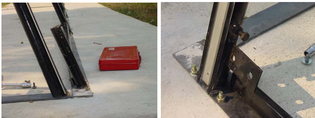
รูปที่ 2.11 แสดงการติดตั้งฐานเครื่องอบแห้งพลังงานแสงอาทิตย์แบบเรือนกระจก
