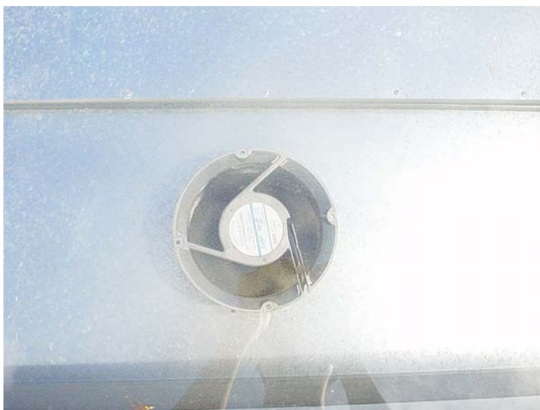
รูปที่ 1.11 แสดงการติดตั้งพัดลมระบายอากาศ
