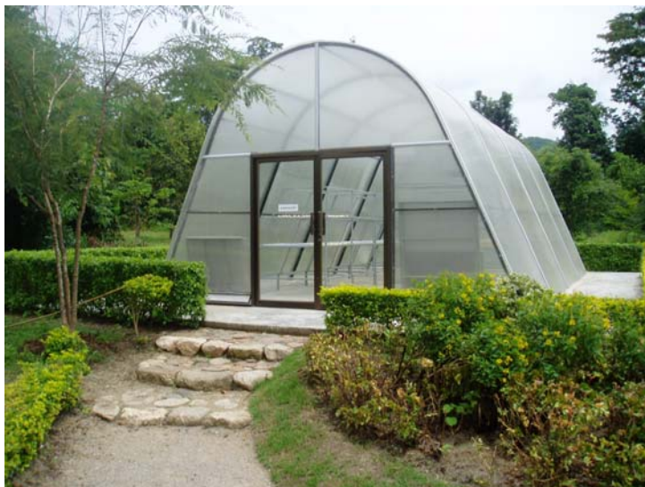
รูปที่ 2.14 แสดงเครื่องอบแห้งที่ประกอบเสร็จเรียบร้อยแล้ว
