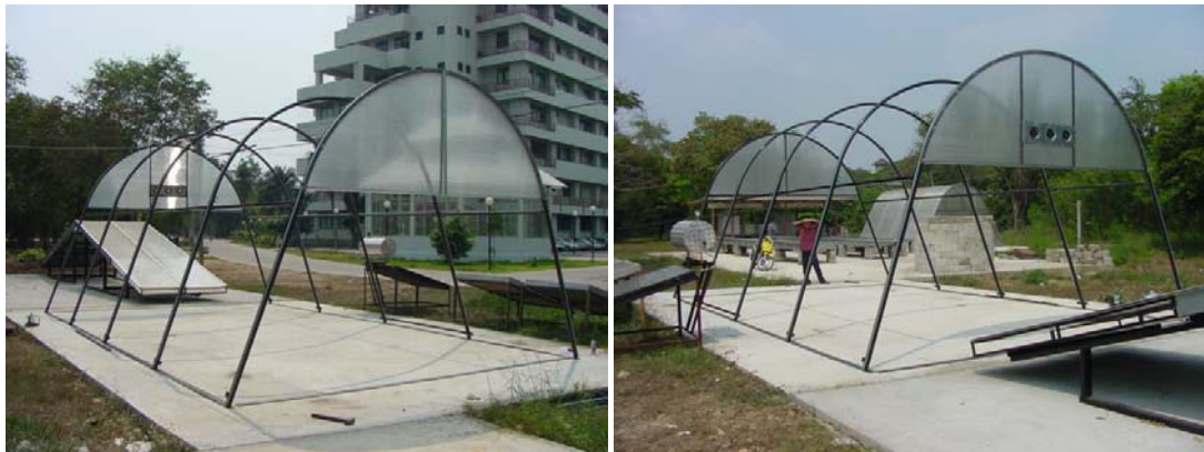
รูปที่ 2.12 แสดงการติดตั้งโครงหลังคา
