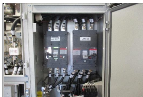
อุปกรณ์ป้องกันเครื่องกำเนิดไฟฟ้า
