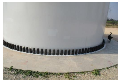
ฐานเสาลม Tower
