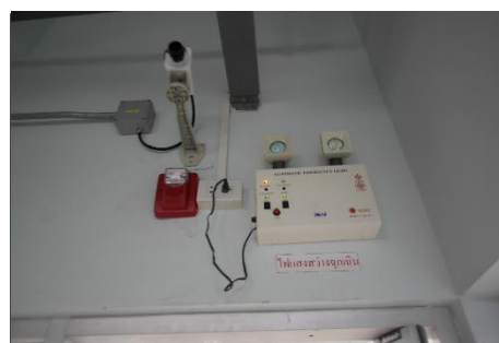
แสงสว่างฉุกเฉินที่ทำงานด้วยแบตเตอรี่
