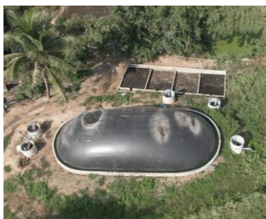
รูปที่ 1 แสดงระบบผลิตก๊าซชีวภาพของชุมชนบ้านเอื้อม
