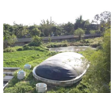
รูปที่ 1 แสดงระบบผลิตก๊าซชีวภาพของชุมชนบ้านเอื้อม
