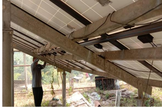
การซ่อมบำรุงตรวจสอบระบบสายไฟฟ้าใต้แผงเซลล์แสงอาทิตย์
