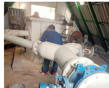
ภาพการติดตั้งเครื่องกั้นน้ำและเครื่องกำเนิดไฟฟ้าพร้อมอุปกรณ์
