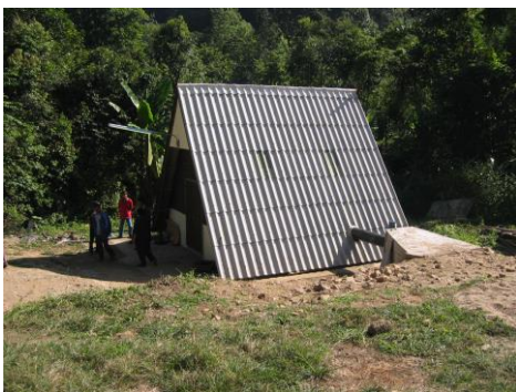
อาคารโรงไฟฟ้า
